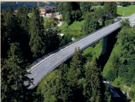
Abb 42: Stützmauer / Lehnenviadukt, Tujetsch
