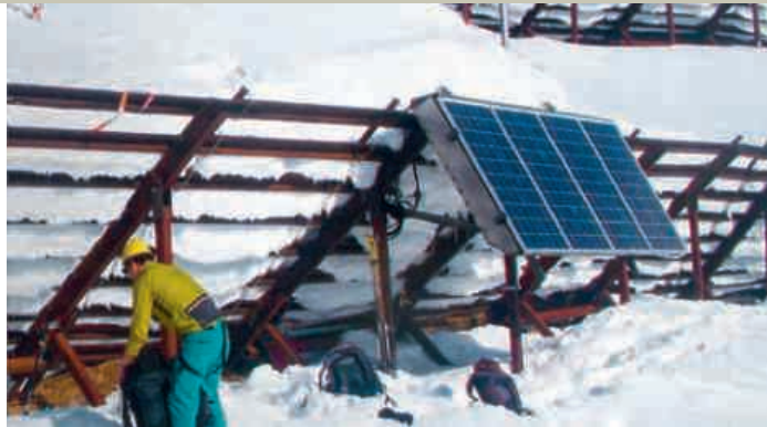
Abbildung 6: Schneeverteilung auf einer der vier Versuchsanlagen in St. Antönien im Winter 2012. Auf dem Stützrost hinter den Solarmodulen hat sich mehr Schnee abgelagert.
