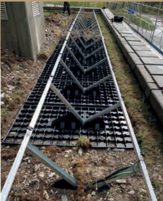
Abb 58: Unterkonstruktion für Photovoltaikmodule (Quelle: Solpic, o. J.)
