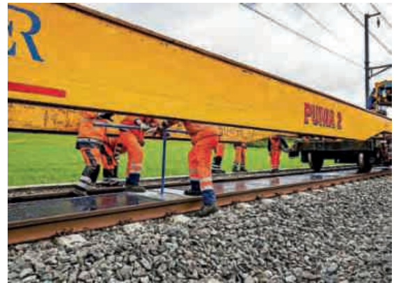
Zwischen den Gleisen: Mit einem Spezialzug werden die Solarmodule verlegt.
